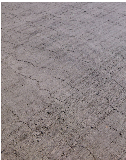
Figur 1.1 – Plastiska krympsprickor i en betong platta (foto; Jonas Carlswärd).
